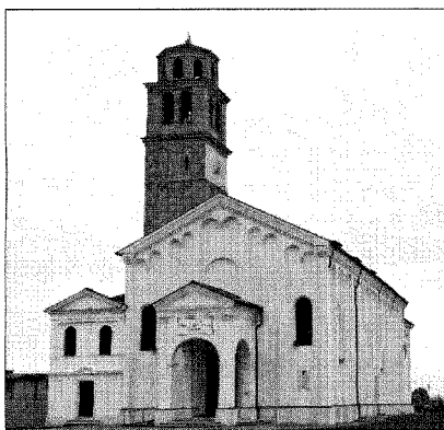
LAVORI la facciata della Chiesa di Gambarare di Mira
